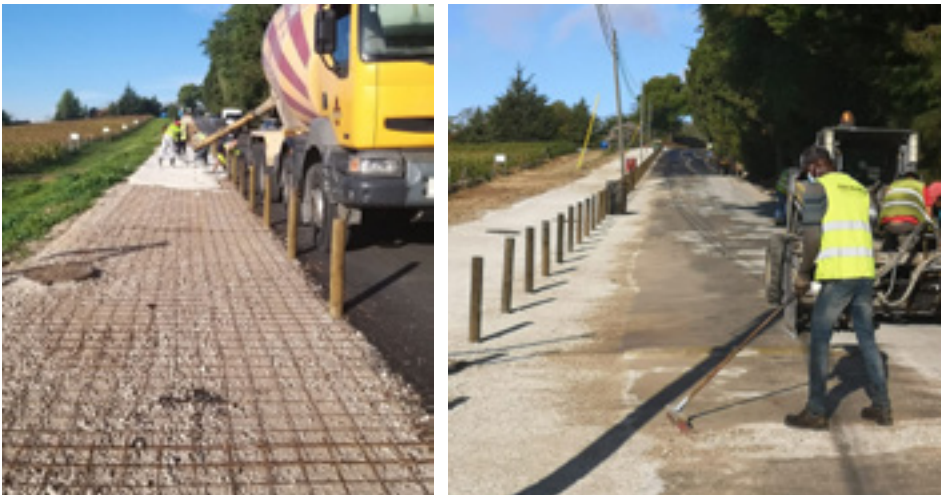
Fig. 81 - Fotografias da obra em execução
