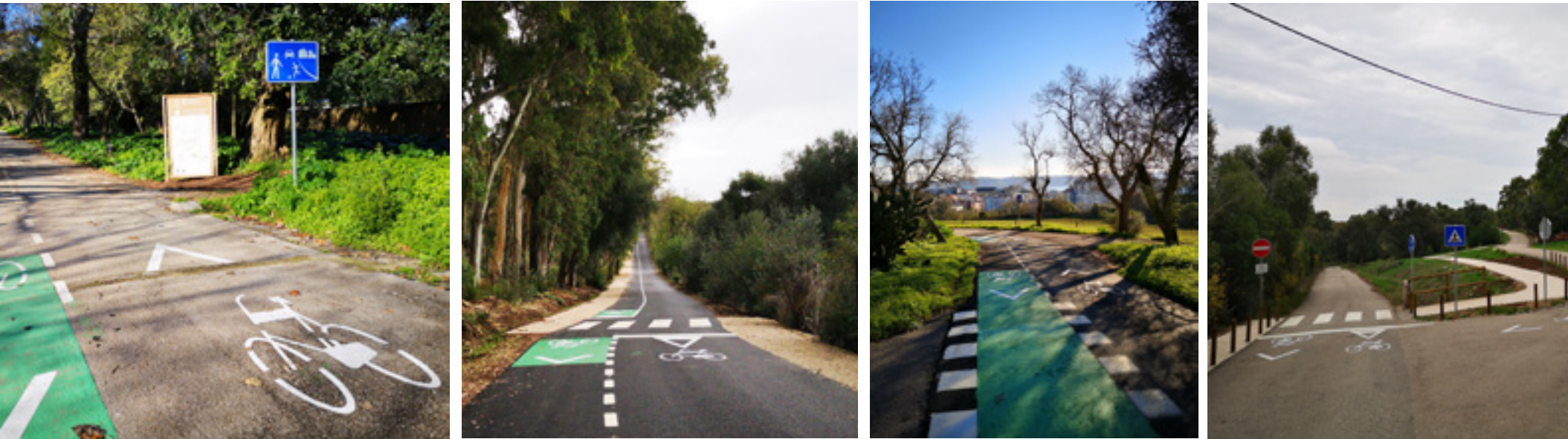
Fig. 80 - Fotografias da obra concluída
