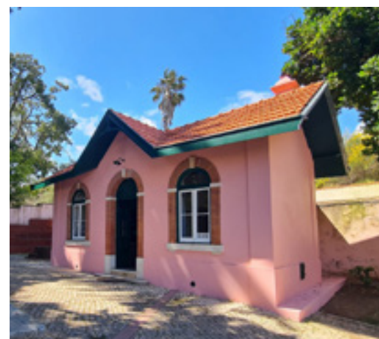
Fig. 35 - Chalet da portaria da calçada da Ajuda (requalificado)
