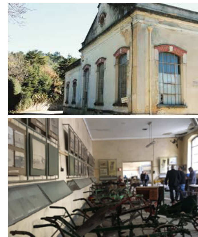
Fig. 29 - Edifício Geradora (existente)
