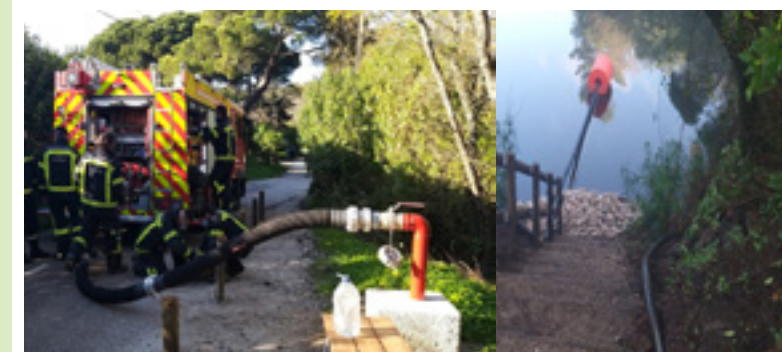
Fig. 96 - Implementação da Rede de Incêndios da Tapada da Ajuda
