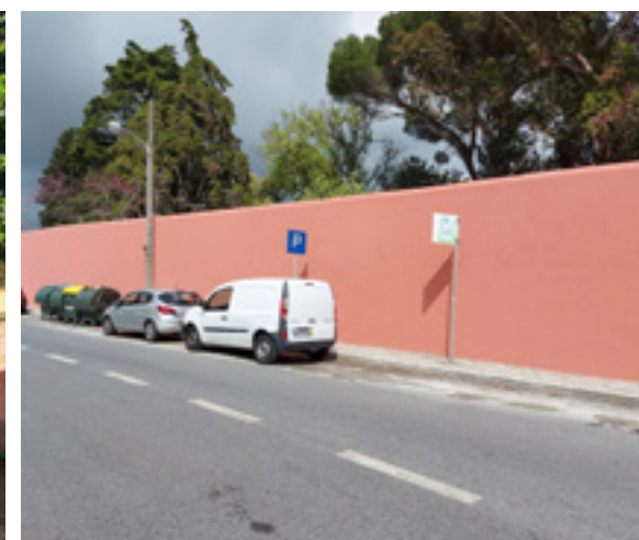
Fig. 36 - Muro da calçada do Galvão (requalificado)
