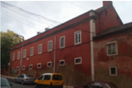
Fig. 50 - Edifícios da Ponte - Estado actual
