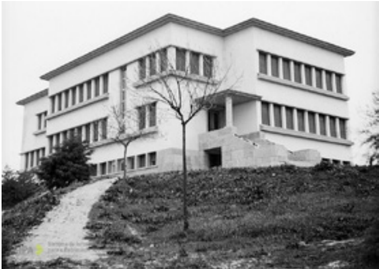
Fig. 18 - Fotografia do Edifício Laboratório Agrícola Rebelo da Silva (Fonte SIPA)
