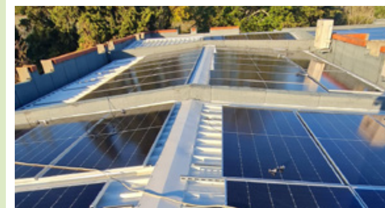
Fig. 99 - Cobertura com sistema UPAC no Edifício Azevedo Gomes
