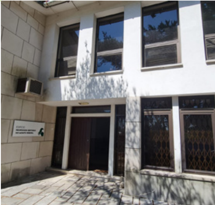
Fig. 24 - Edifício Sertório do Monte Pereira antes e depois das obras
